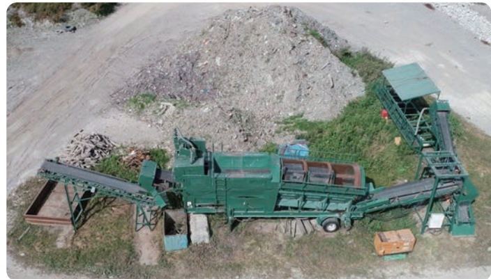
がれき類 混合残土・すき取り物
